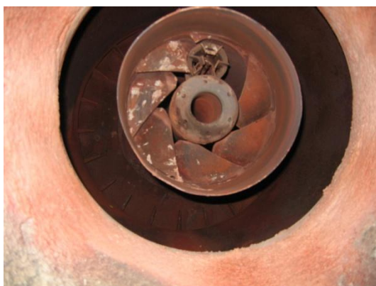
Quemadores, parte interior de la caldera.
