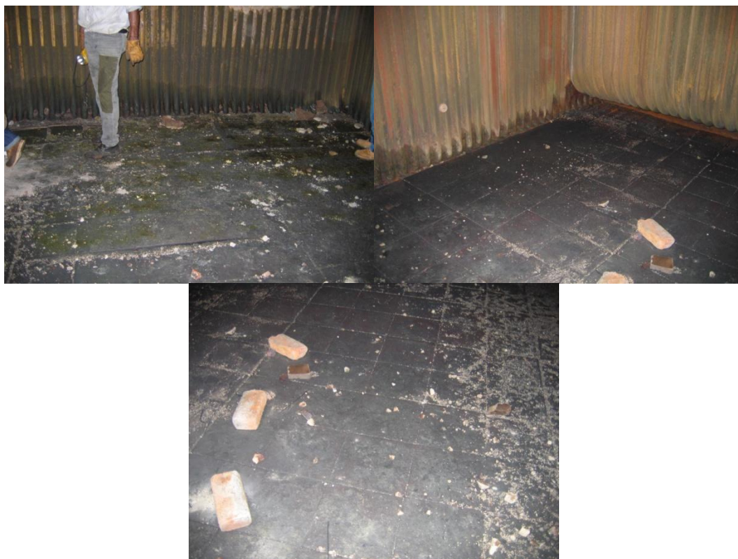
Piso del hogar de la caldera, ladrillos refractarios.
