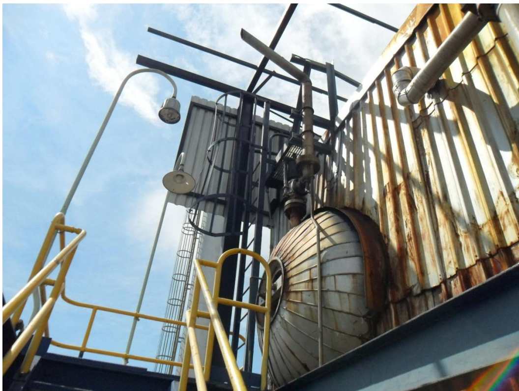
Ventoe, válvula de seguridad 915 PSI, tambor de vapor – Caldera unidades 1 y 2.
