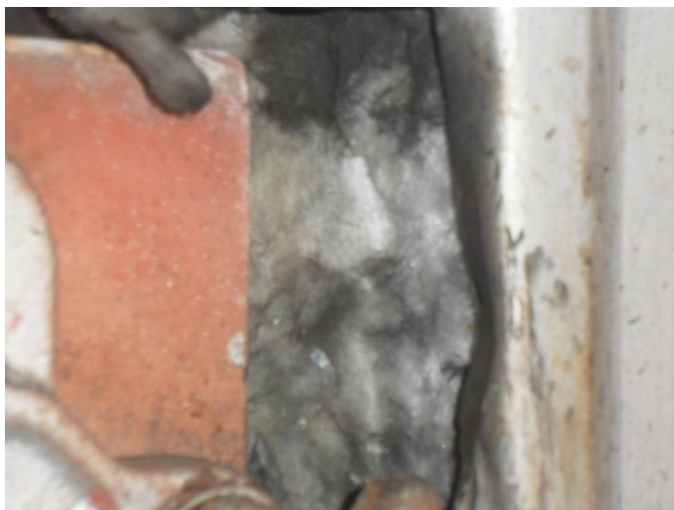
Colchón de lana de vidrio, aislamiento térmico, láminas protectoras desubicadas, color oscura (detección de fugas).
