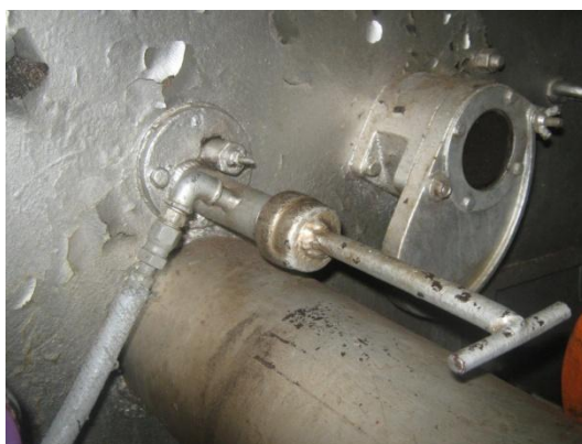
Caña de encendido, Fococelda, Mirilla – Quemador.
