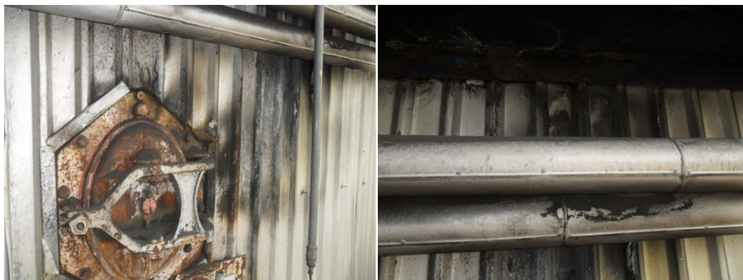
Láminas protectoras, aislamiento térmico, marca de ceniza (detección de fugas).
