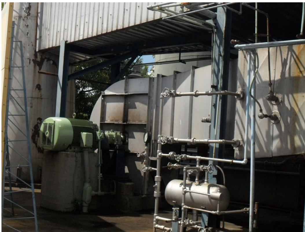
Ventilador tiro forzado (VTF), precalentador – Caldera unidades 1 y 2.
