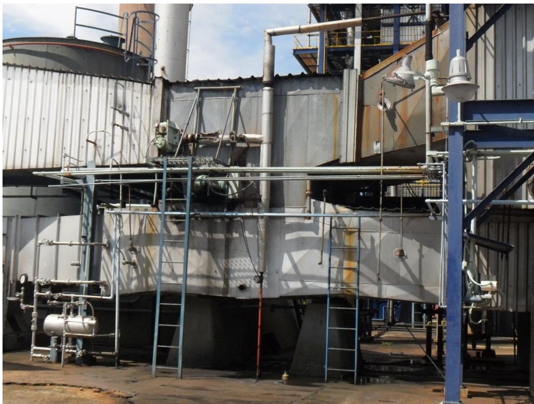
Calentador de aire rotativo (CAR) – Caldera unidades 1 y 2.
